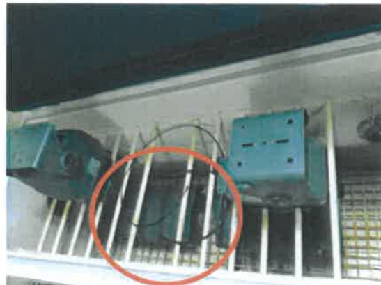
그림 2) 시험품 설치 사진
