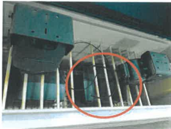
그림 2) 시험품 설치 사진
